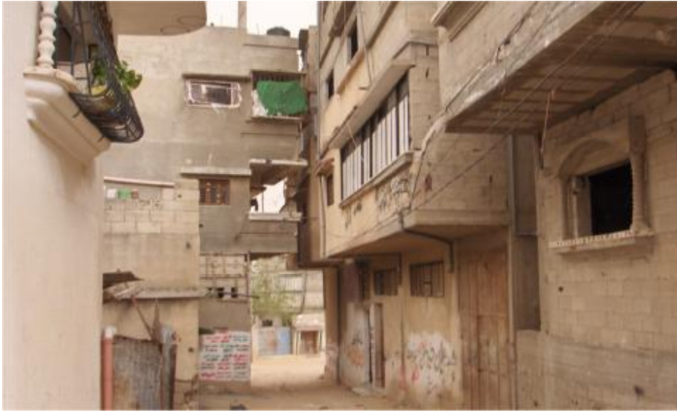
شكل (3-2): منازل تخالف قوانين الارتداد في مدينة جباليا مما أدى إلى فقدانها لخصوصيتها المصدر: (الباحثة)
