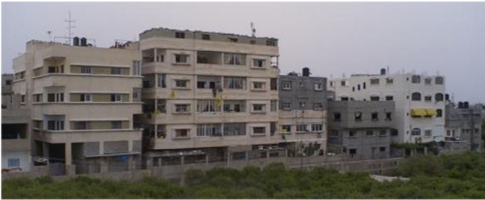
شكل (3-3): منازل تخالف قوانين الارتداد الجانبي والخلفي المنصوص عليها بـ2م علماً أن هذه الواجهة الخلفية للبنىات والسور هو حد البناء - جباليا، المصدر: (الباحثة)
